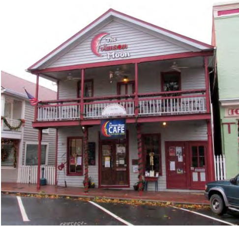
The Parker Storehouse
